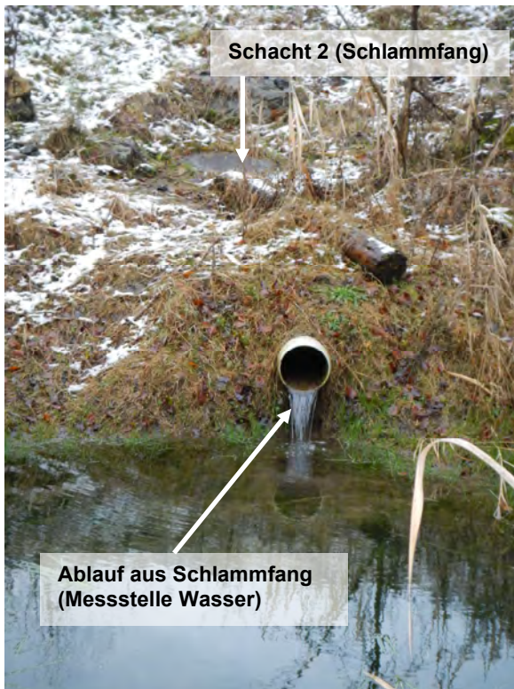
Messstelle Schacht 2 (Schlammfang – S2)
